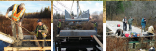
La construction du Sentier en Nouvelle-Écosse et au Québec.
