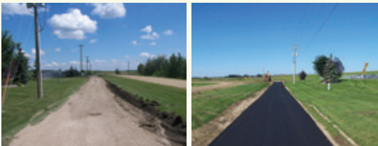
Le sentier de Lacombe County, avant et après les travaux de pavage.
